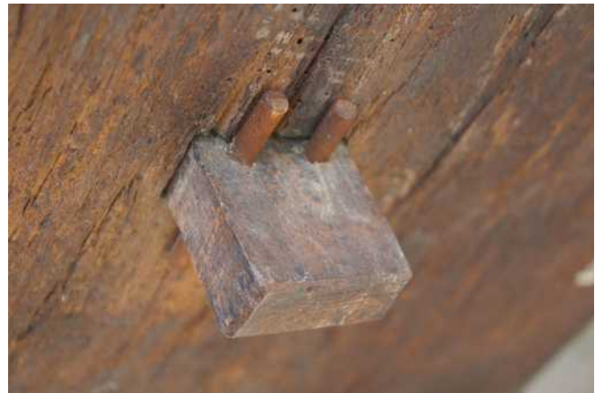
15. ábra. Az újra összeállításnál tölgyfából készült fa-csapokat használtunk fel
