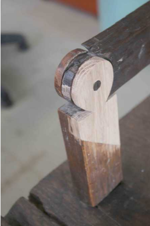
13. ábra. A kiegészítéseket az eredetinek megfelelően tölgyfából készítettük el
