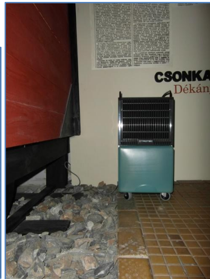
Páramentesítő készülék a Vagonba zárt nemzet kiállítótér főtermében
