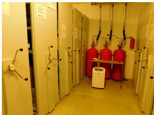
1.-2. kép A könyvtári raktárban elhelyezett páramentesítő készülékek
