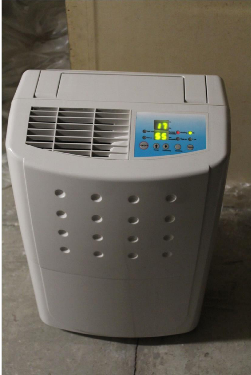
1. fotó. AP WDH 735 páramentesítő készülék beüzemelt állapotban
