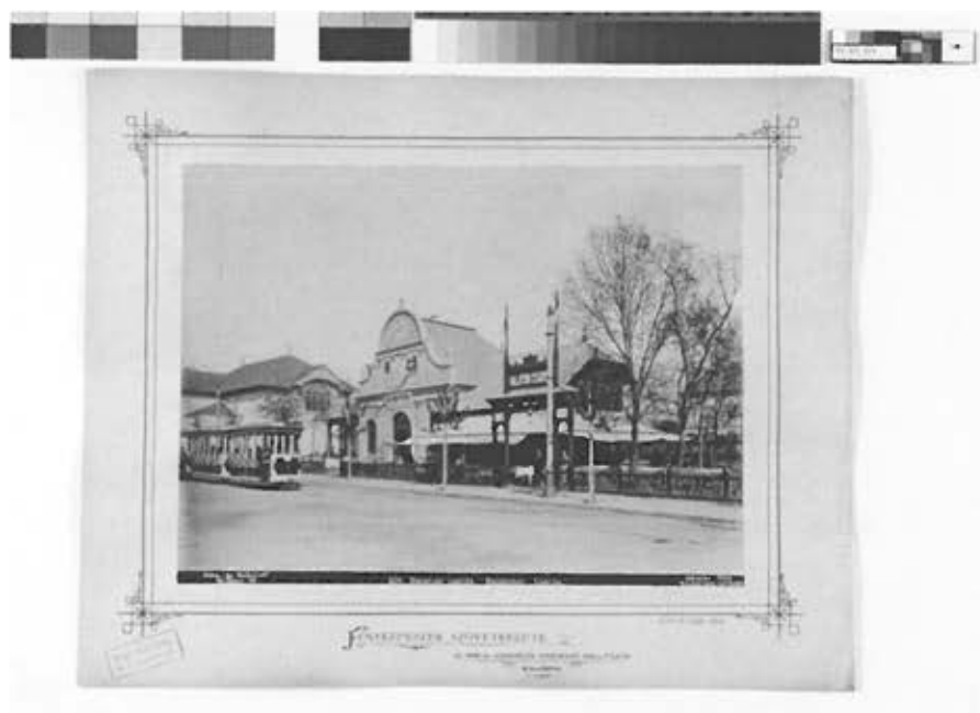
13. kép A 14. oldal restaurálás után
